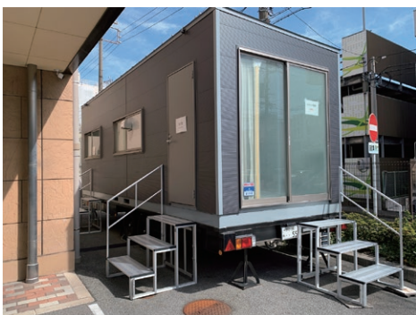
駐車場にトレーラー(建築確認申請不要)
